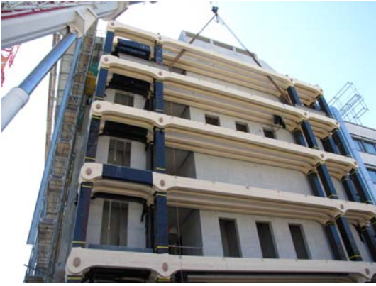
Ab April 2012 wird die Holzkonstruktion zusammengebaut.
