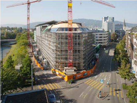
Die Fassade wird im Oktober 2012 geschlossen.
